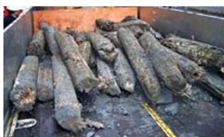
旧ビルに基礎として使用されていた松杭の撤去
